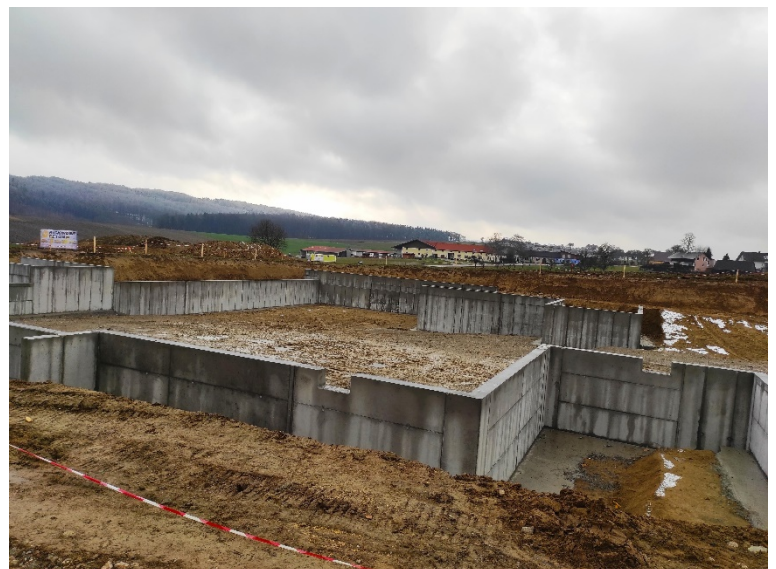
Der Baustellenfortschritt Anfang Jänner 2021
